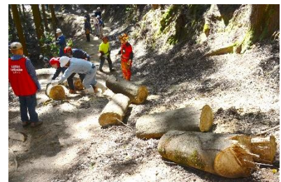
切断した危険木の撤去
