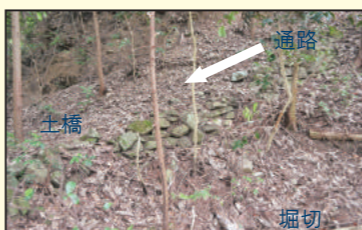
通路から土橋に残る石積(北側より撮影)
