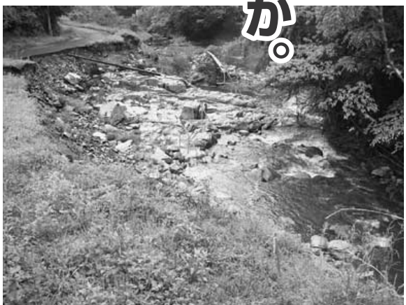
八千代町根の谷地区、根の谷川が護岸をえぐりとった。普段の水量からは考えられないような水量が、この雨で流れたことを物語る。
