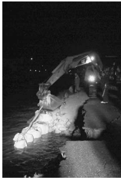
吉田町吉田の高樋の堤防が決壊寸前までだった。危険性を考えて重機での対応を決定。大きな土のうを積み、決壊を防いだ。
