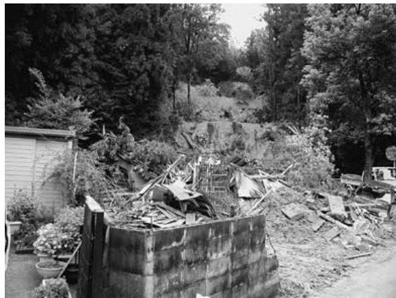
吉田町吉田の上迫地域の土砂崩れ。土砂は正面にあった家を全壊させた。
