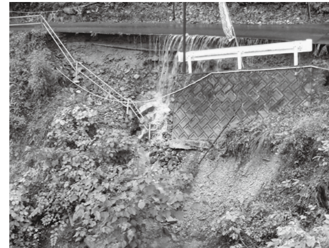
(上) 八千代町の市道潜龍線 (8月20日撮影)。(右) 向原町の林道虫居谷線 (7月20日撮影)。どちらも豪雨により路肩が崩れている。
