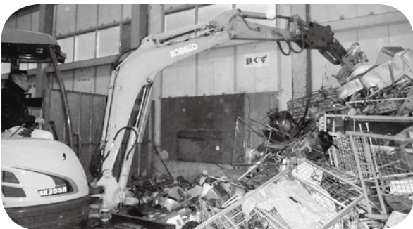
手作業から重機作業へ
