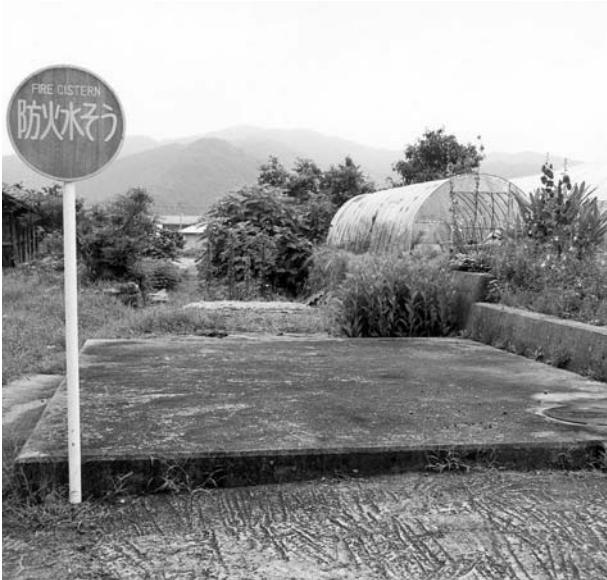
防火水槽は18年度9基建設予定
