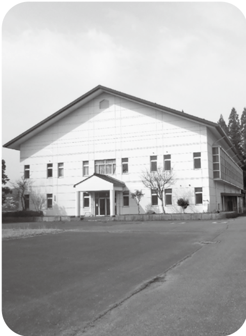
改修工事が予定されている 高宮中学校校体育館
