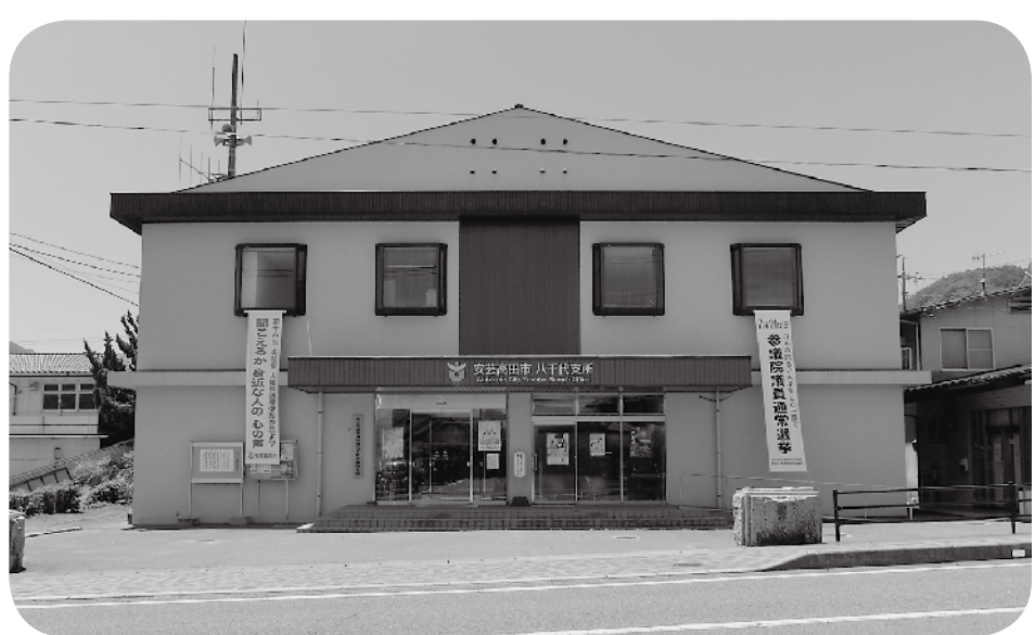
整備計画が凍結されている八千代支所
