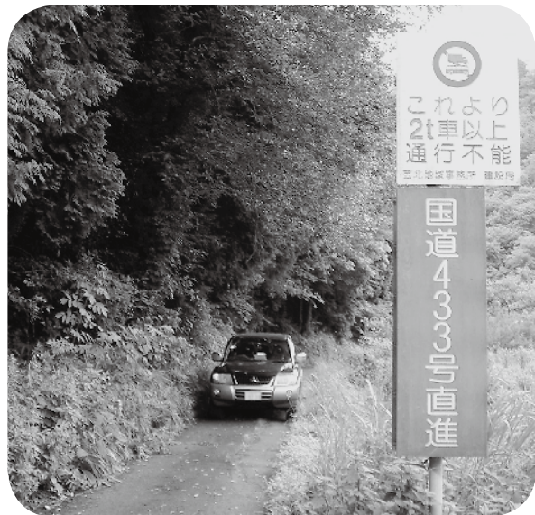
国道433号線の現状
