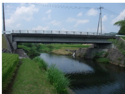
美土里橋 L = 30.0 m (PC橋) 1978年 架設
