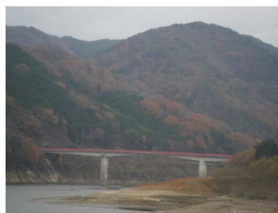
土師大橋 L = 189.1 m (PC橋) 1972年 架設
