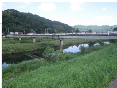
可愛橋 L = 156.3 m (PC橋) 1968年 架設
