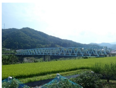
香淀大橋 L = 204.2 m (鋼橋) 1985年 架設
