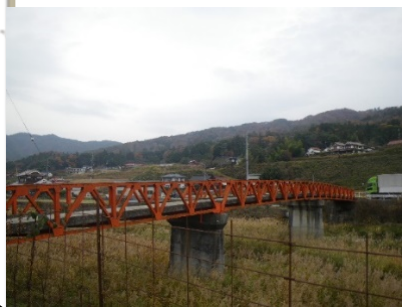
鹿洲橋 L = 51.5 m (鋼橋) 1971年 架設
