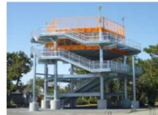
津波避難タワー
